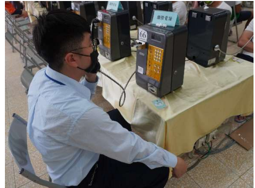
中華電信人員進行故障排除
